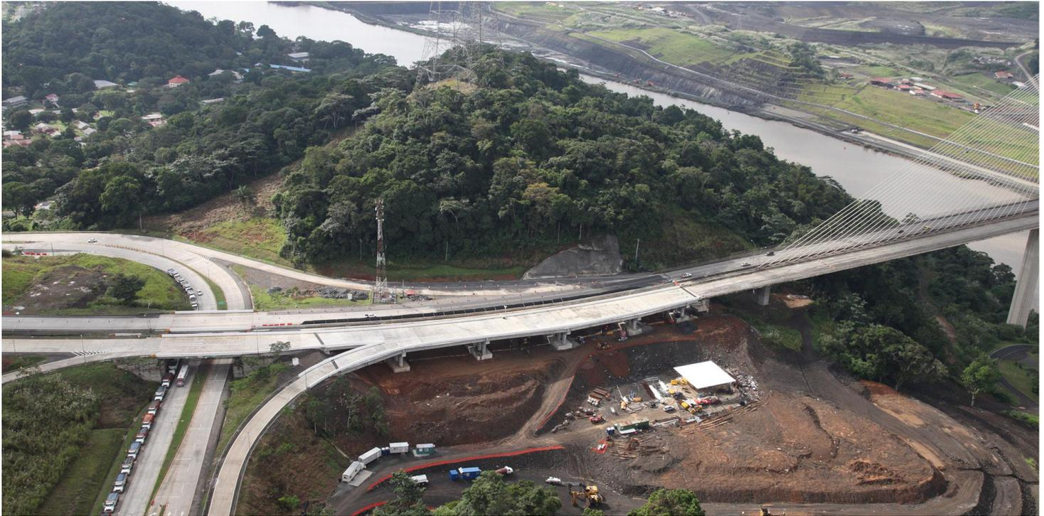
El deslizamiento producido en la calzada norte del acceso al Puente del Centenario ha obligado a la realización de una serie de trabajos encaminados a la restitución del tráfico y a evitar futuros problemas asociados al deslizamiento de la ladera. Estos trabajos incluyen la realización de una pantalla permanente de pilotes en el eje de la mediana cuya intención es la de contener las tierras de la ladera y la ejecución un puente a continuación del Puente del Centenario.
